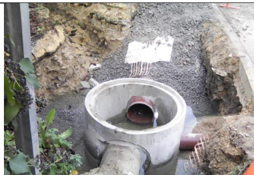
Figure 5b : réseau EP et AEP Le Vanneau
