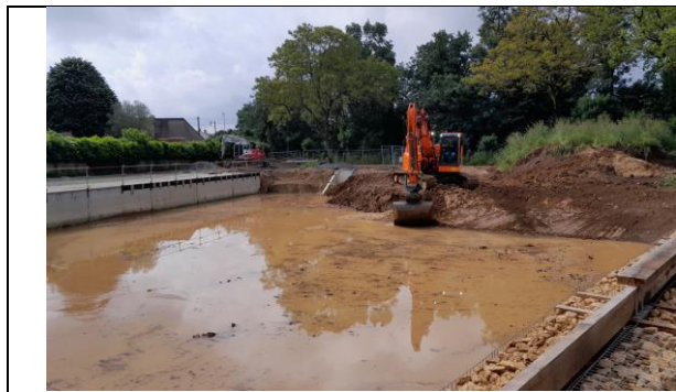
Figure 5a : terrassements bassin Espace Lambon (Niort)
