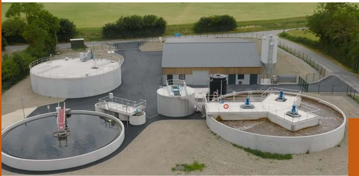
Renouvellement Station d'épuration de Mauzé/Mignon
